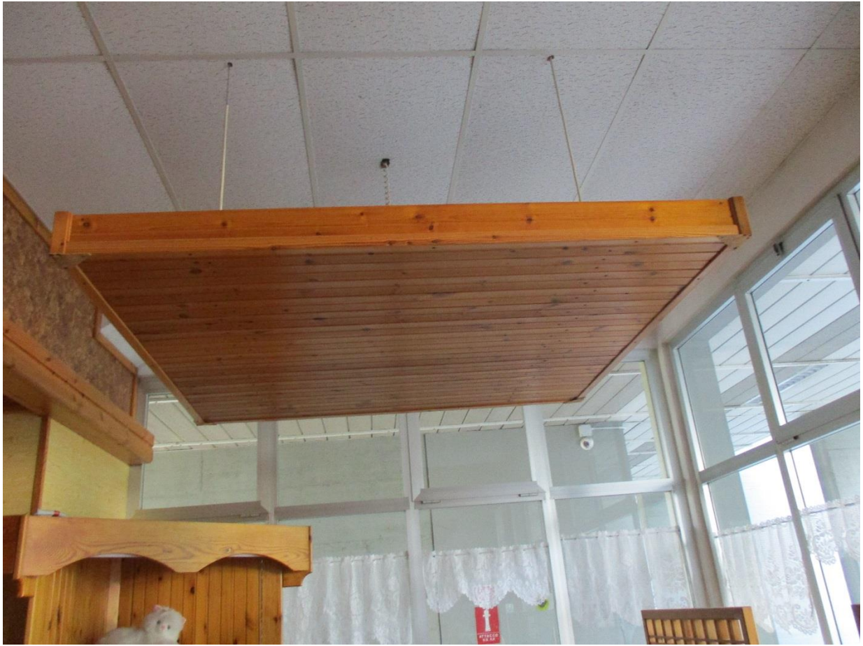
Figura 5: dettaglio del soffitto
