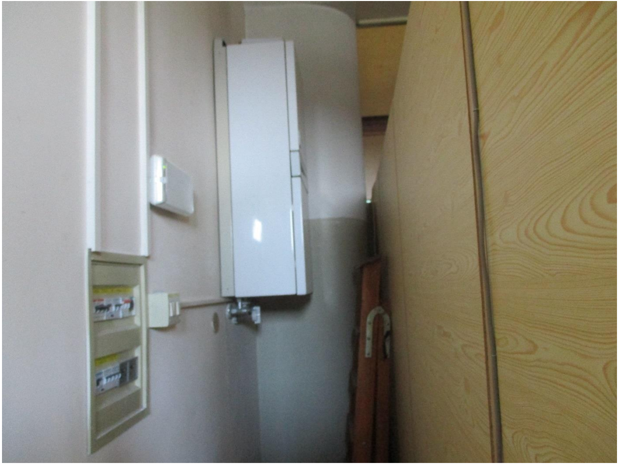
Figura 9: caldaia murale
