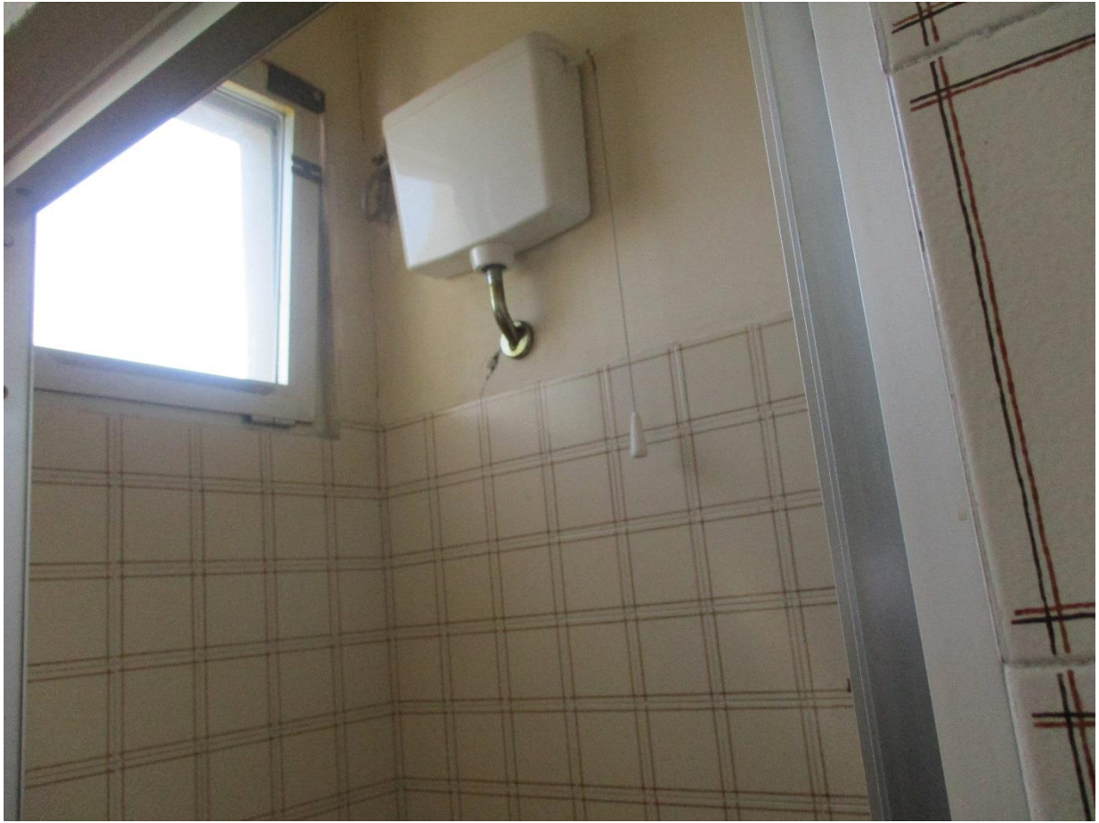
Figura 10: particolare del w.c.
