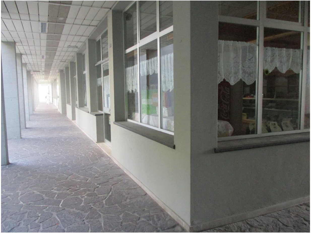
Figura 1: il locale visto dalla galleria.
